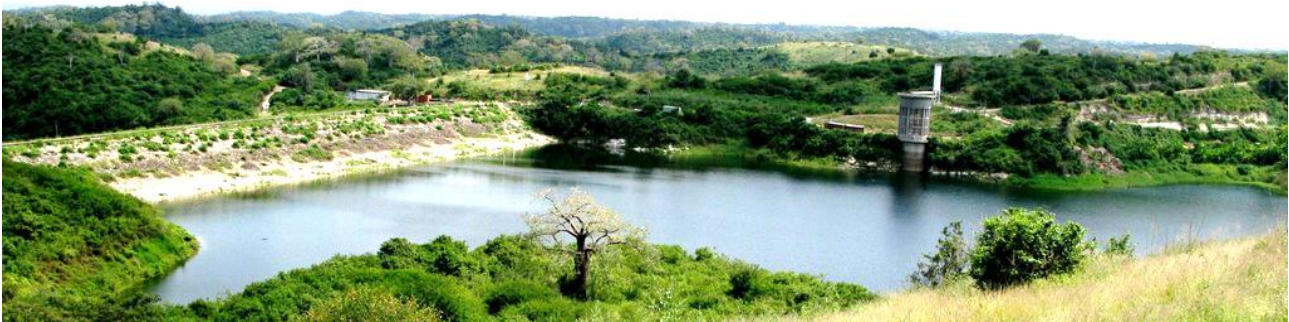
Figura 1 – Vista geral da Barragem da Quiminha
