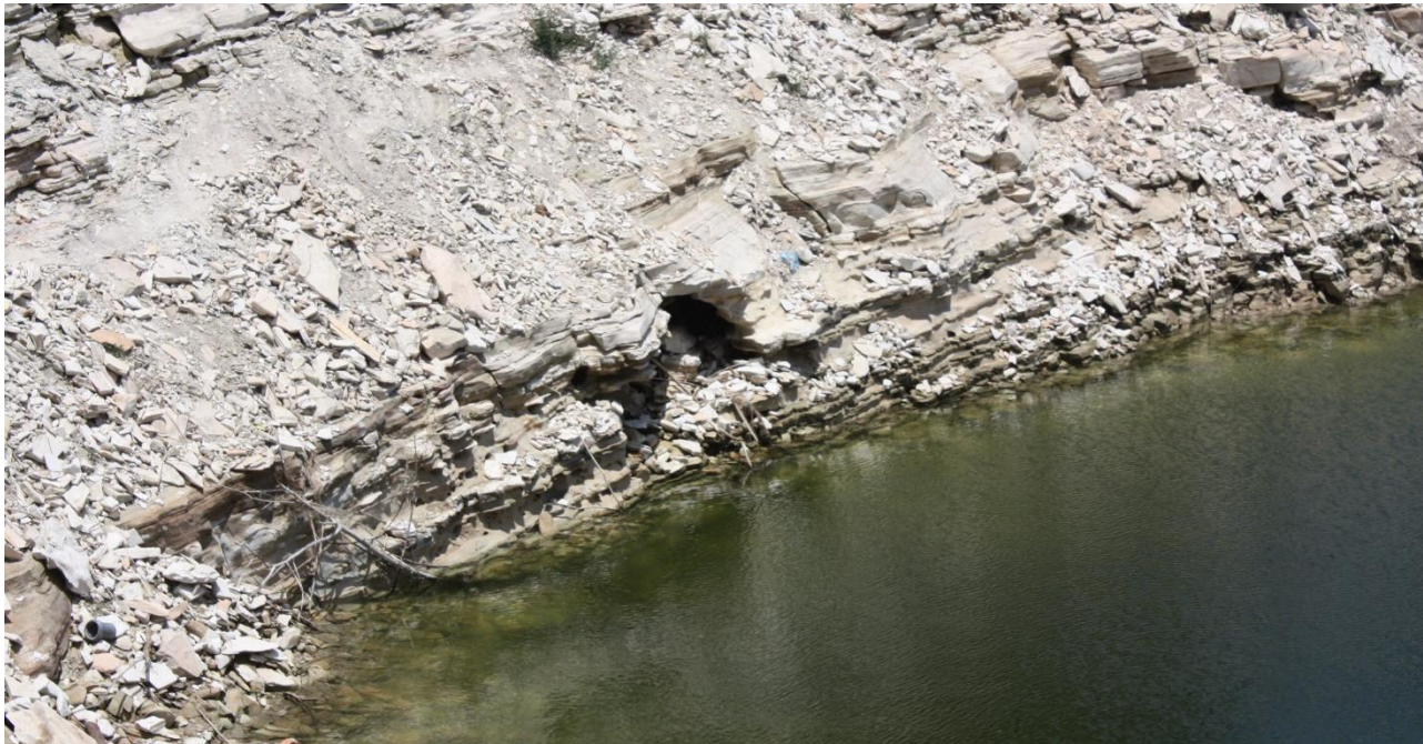
Figura 3 – Vista do maciço calcário do encontro da margem direita da barragem, sendo possível observar a existência de uma cavidade de significativas dimensões
